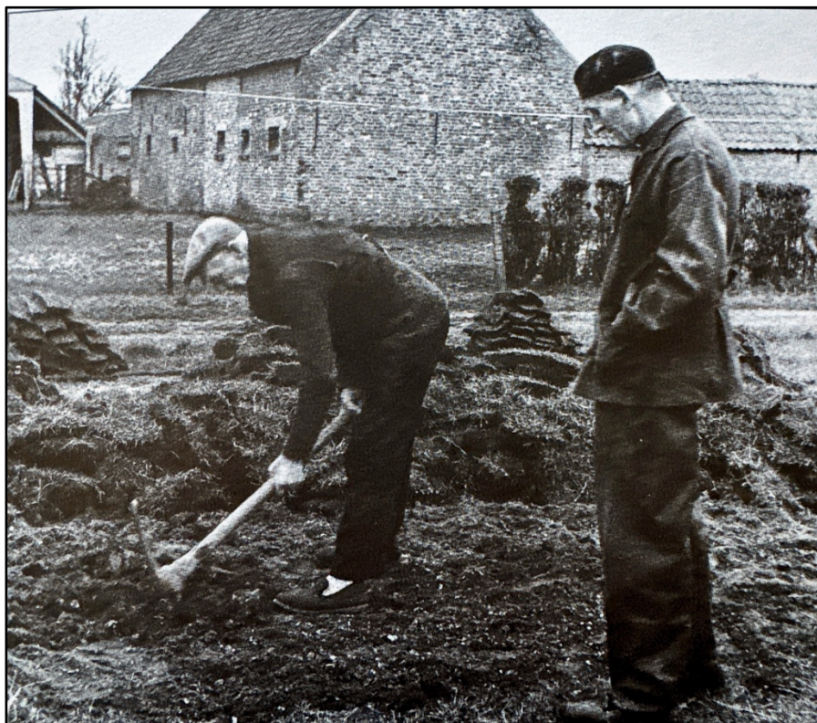
Eerste spadesteek door Gustje Mortier samen met bouwpastoor Ackaert.
